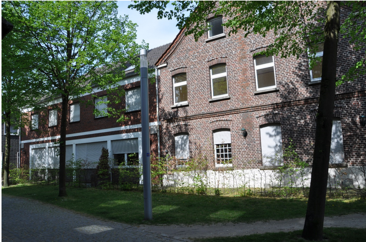
Bild 1 – Südansicht mit Anbau
